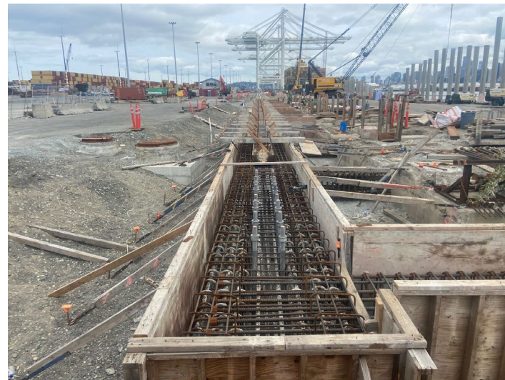
Final LSCR Concrete Pour
